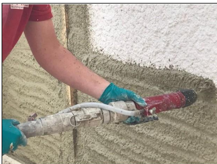
Figure 10 - Projection d'un enduit chaux chanvre - Source Parnatur Parex chaux chanvre © CG. Batiactu
