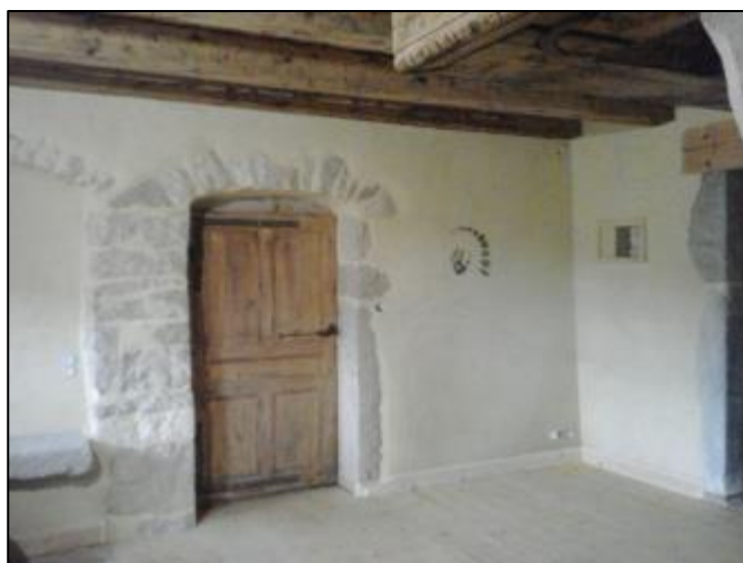
Figure 9 - Enduits réalisés dans une vieille ferme typique du Haut-Jura. Source : https://etsilaterre.lautre.net/
