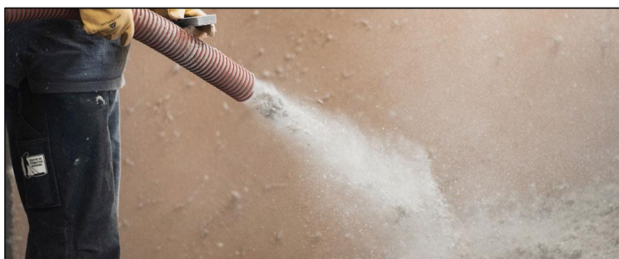
Figure 16 - Soufflage de fibres de ouate de cellulose. Source : Soprema
